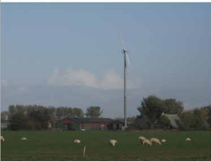
turbine op het boerenerf, type Lagerwey
