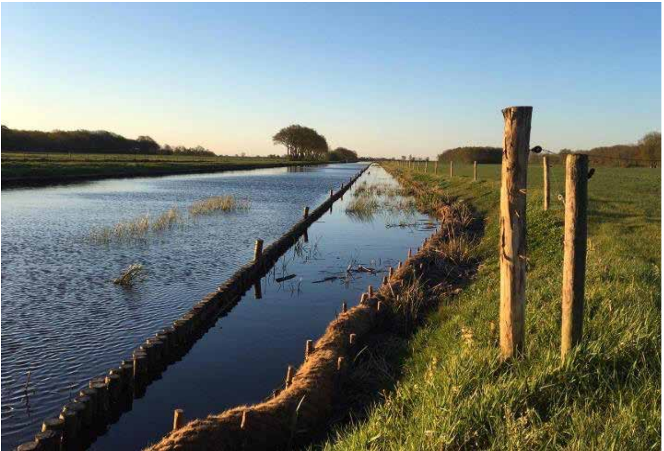
Voorbeeld aanleg natuurlijke oever langs wetering; goed voor waterberging, waterkwaliteit, biodiversiteit, landschappelijke belevingswaarde en daarmee voor recreatief medegebruik (foto: Wetterskip Fryslân)
