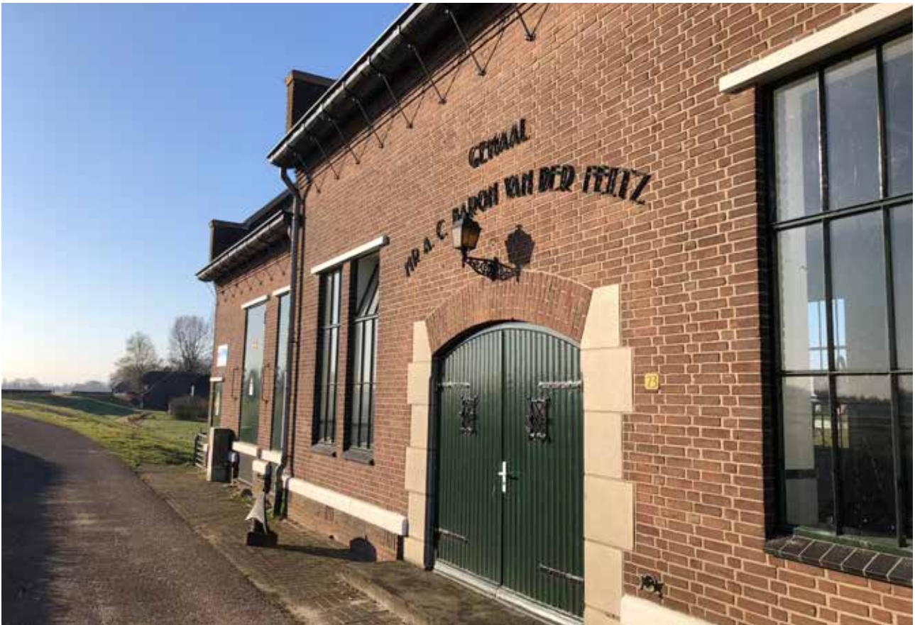
Gemaal Terwolde. Mogelijk onderdeel bezoekerscentrum 'klimaat en water'.
