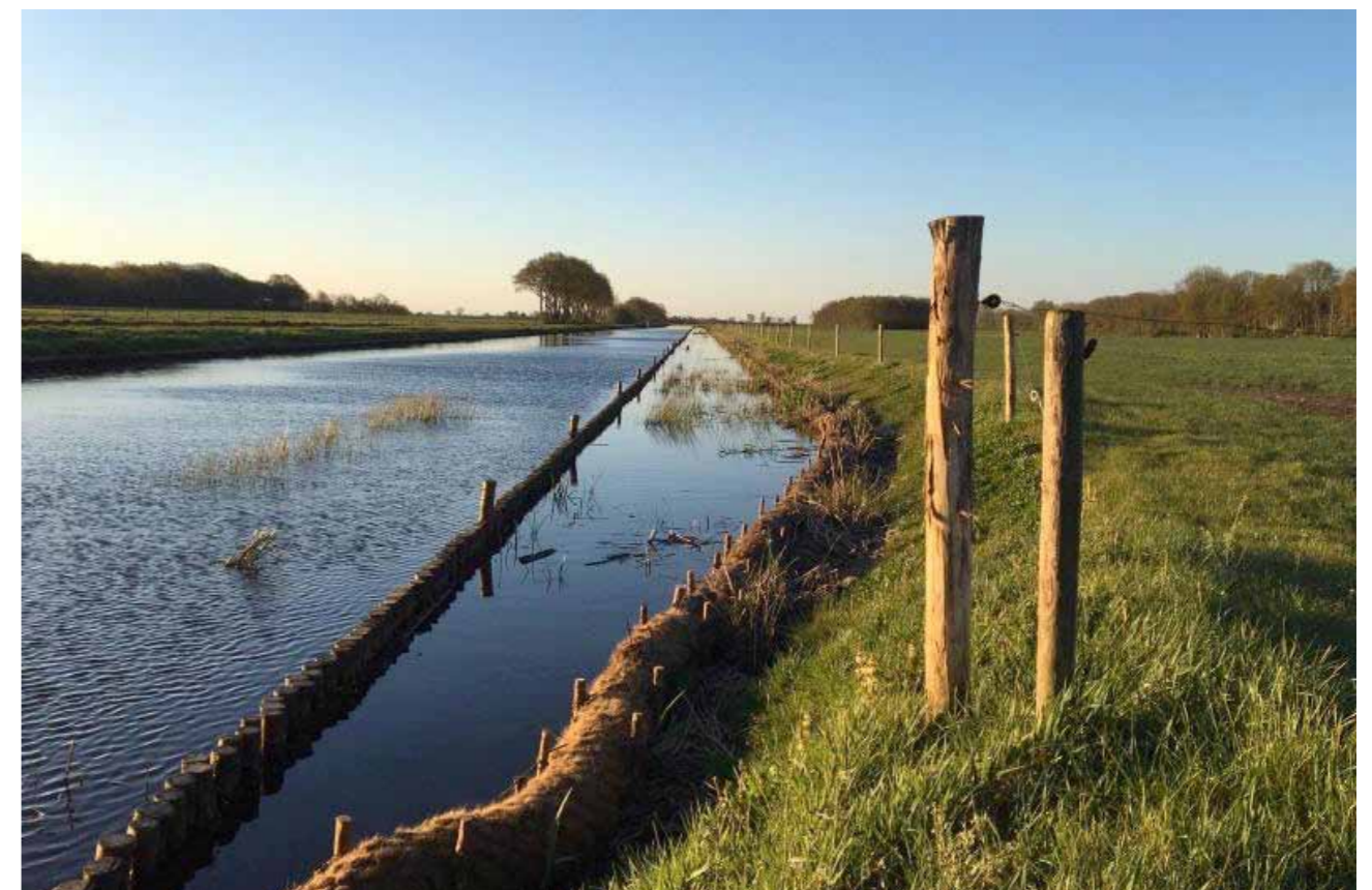
Aanleg natuurlijke oever in weteringengebied noordelijke IJsselvallei, goed voor waterberging, waterkwaliteit, biodiversiteit en landschappelijke belevingswaarde (foto: Wetterskip Fryslân)
