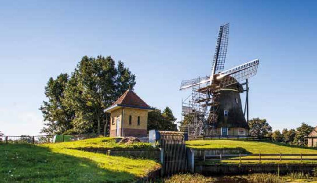
Drie generaties bemaling van de polder De Grie in de buurt van Heerenveen (foto: Wetterskip Fryslân)
