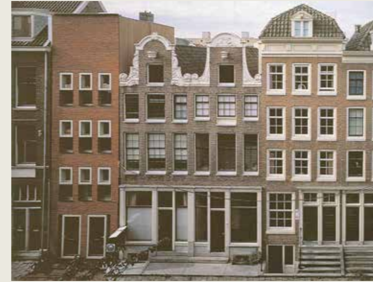
Moderne herenhuizen die de morfologie van de stad herstellen en een eigentijdse interpretatie geven van een klassiek gevelritme: woningbouw aan de Hoogte en Laagte Kadijk, Amsterdam, Claus en Kaan Architecten
