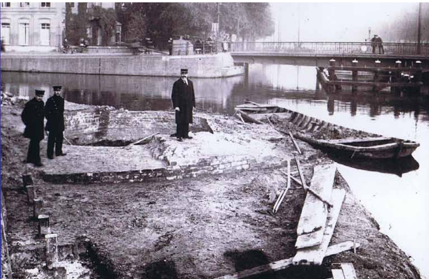
Het fundament van de pijnigstoren, 1919.
