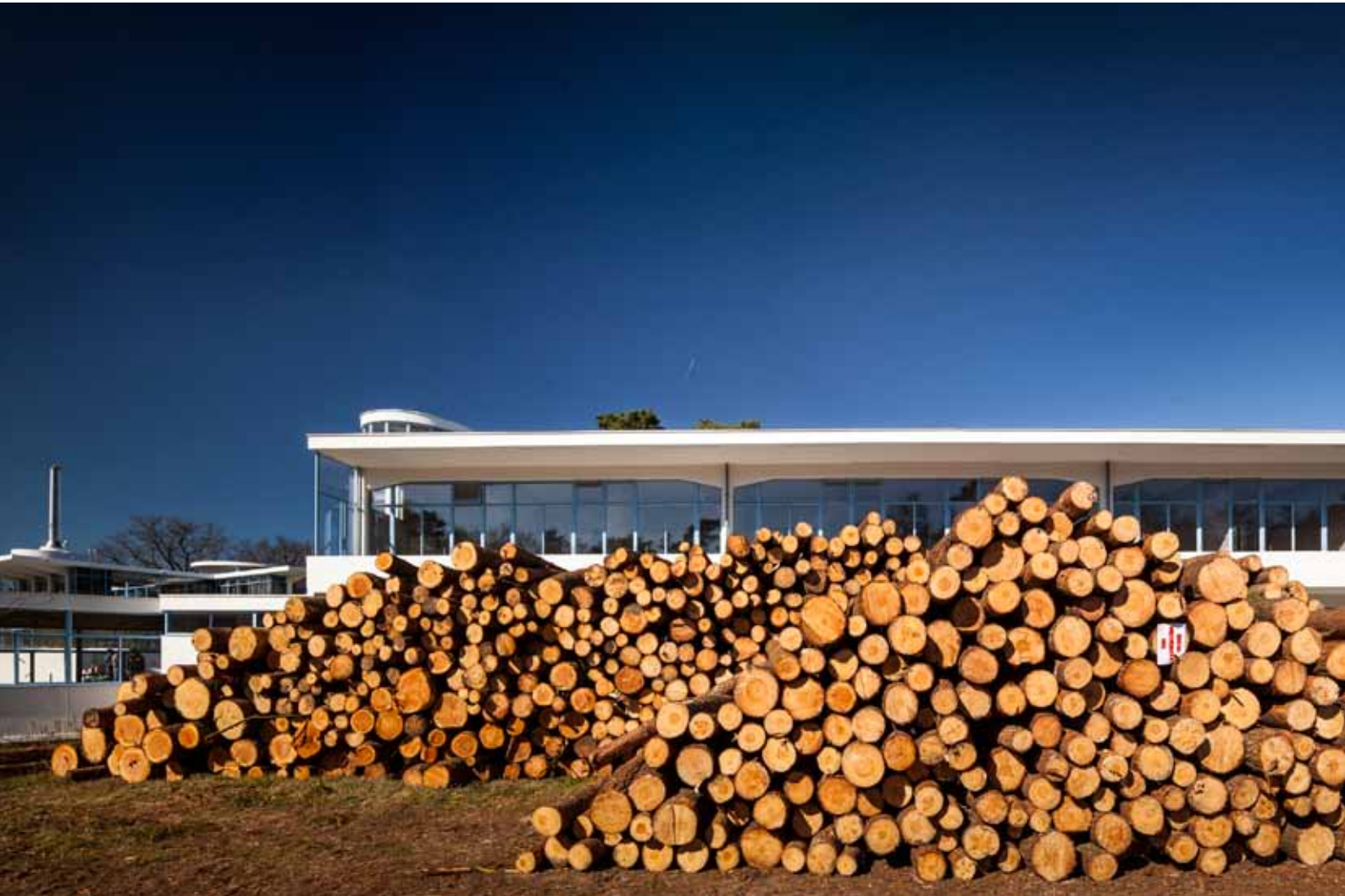
De tijdelijke opslag van hout voor het Dresselhuijs-paviljoen.
