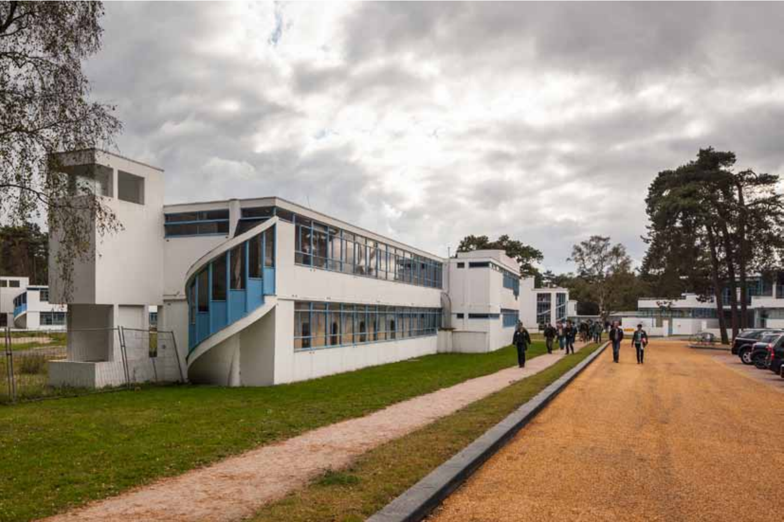
Nieuw voetpad tussen het hoofdgebouw en de heringerichte parkeerplaatsen.
