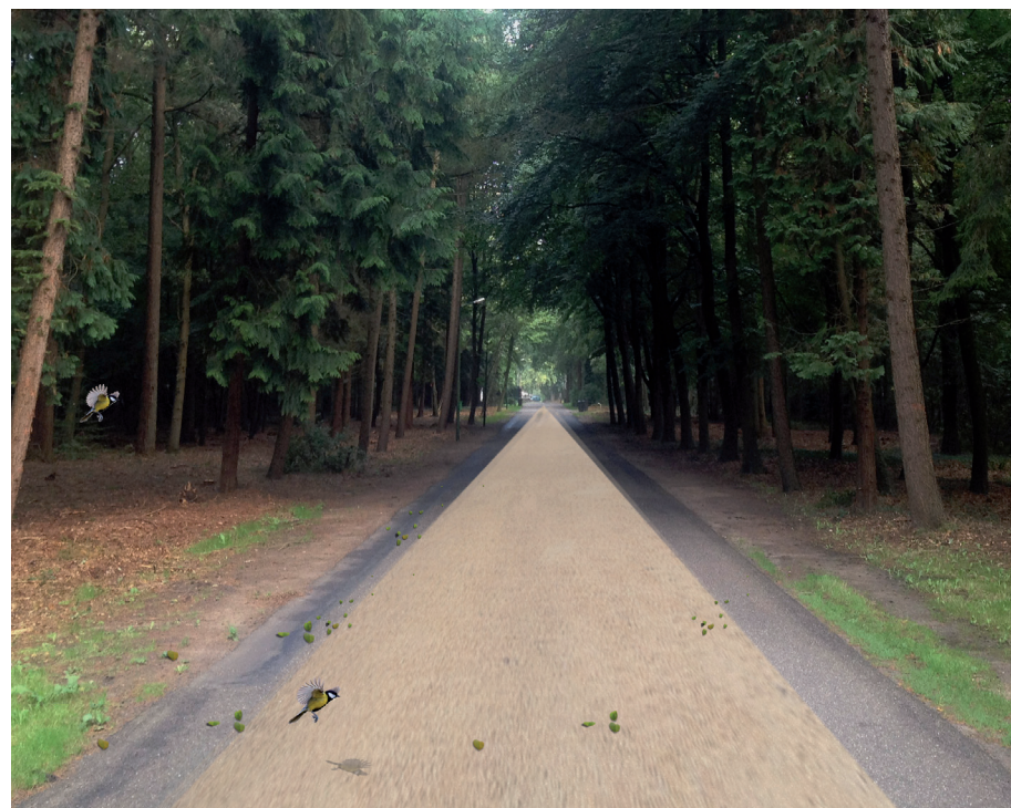
Impressie zandkleurige toplaag op asfalt entreeroute landgoed Zonnestraat.
