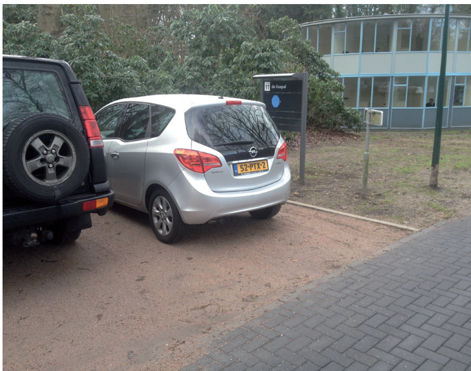
Gebruik Schots graniet als halfverharding voor alle parkeerplaatsen op Landgoed Zonnestraat. Voorbeeld laat heringerichte parkeerplaats bij Pampahoeve zien. Haag van liguster moet nog worden geplant.
