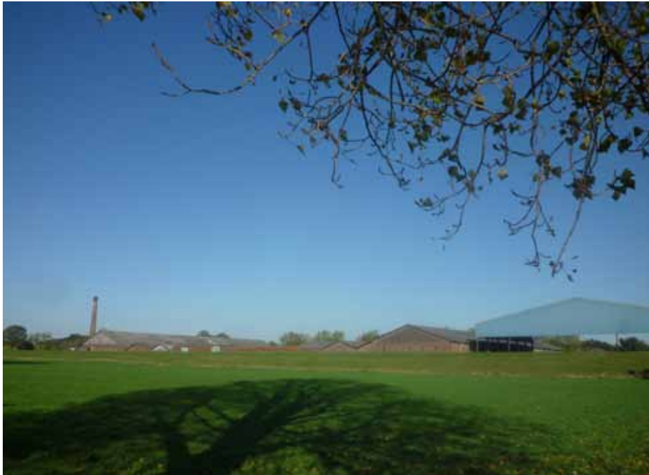
Beeld steenfabriek vanaf de Maas achter de hoogwaterbeschermingsdijk
