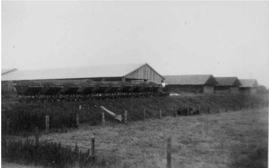
Kleitransport met smalspoor en 'kipwagens' over dijkje tussen uiterwaarden en fabrieksterrein (bron Stichting Cultuurbehoud Milsbeek)
